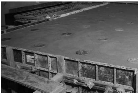
Rys. 14 Zabetonowana płyta wielkich sił i wykres rozkładu temperatury w płycie i w powietrzu [1]
