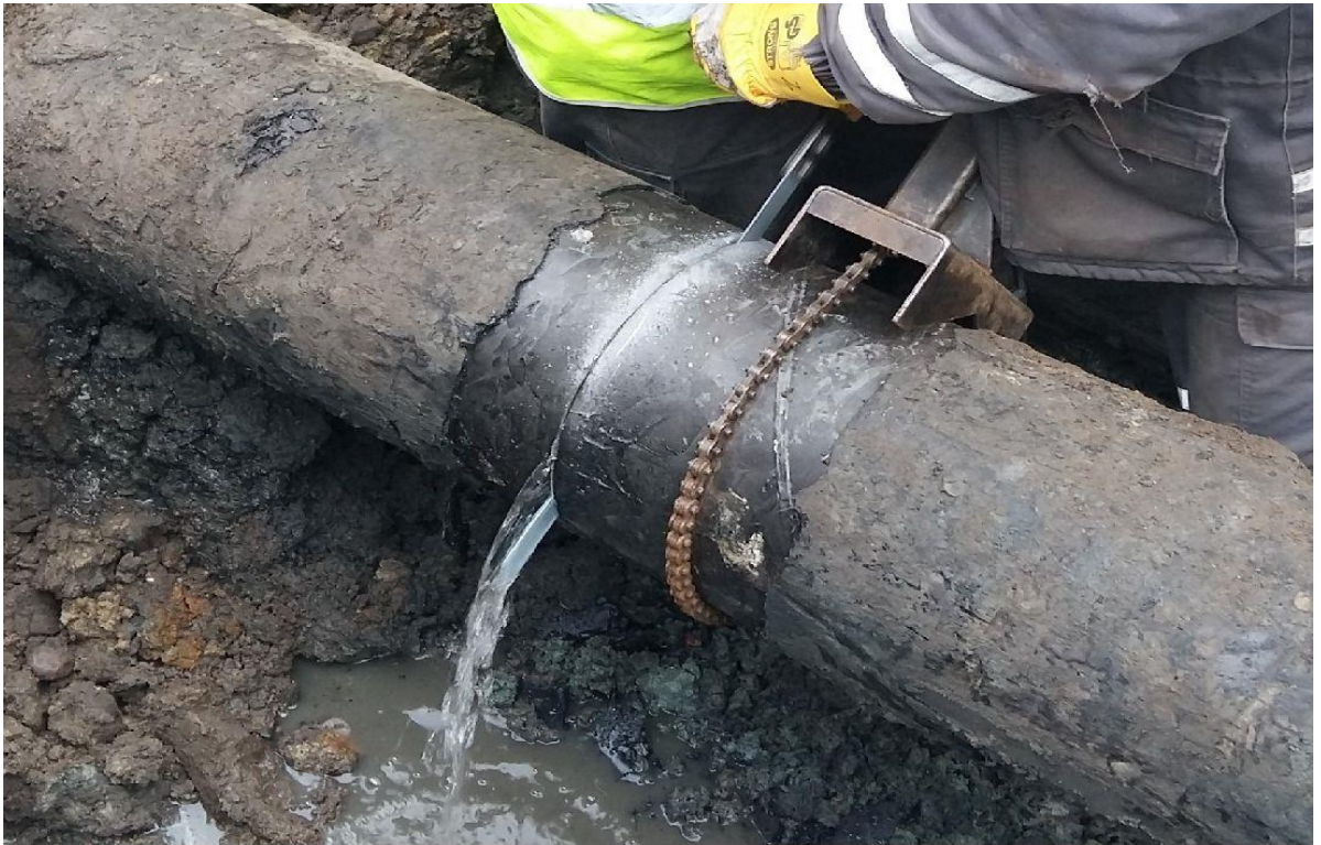
Foto. 1 - Cięcie gazociągu DN300 w ulicy Myśliwskiej w Kołobrzegu
