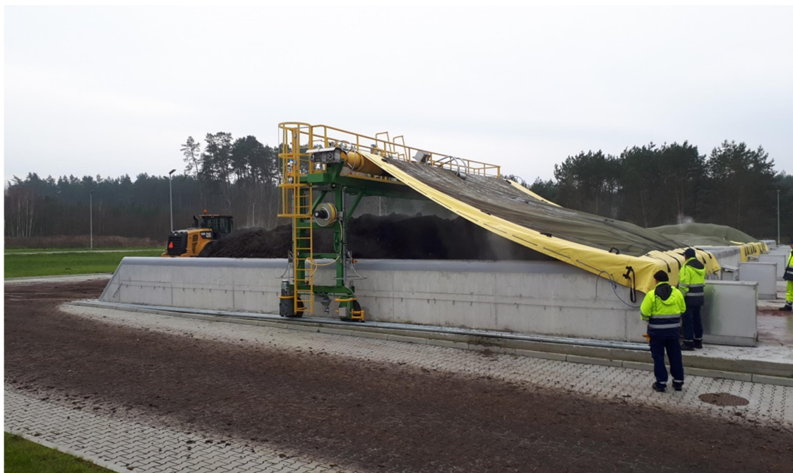
Rys. 8. Montaż membrany typu GORECover na pryzmę kompostową – II. część badań
