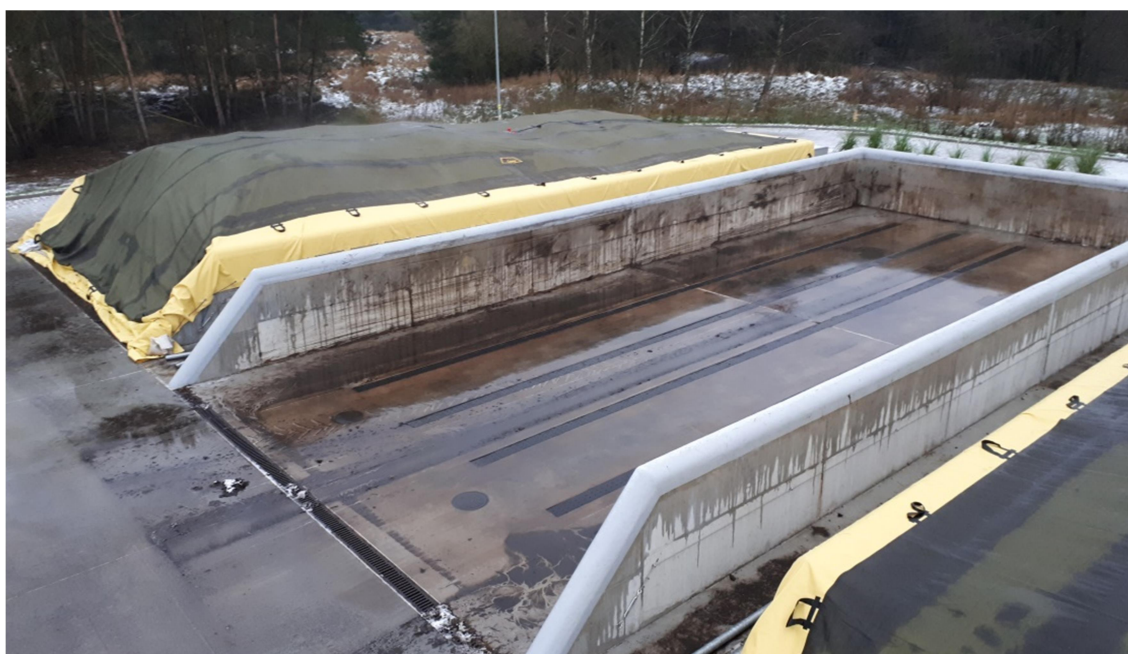
Rys. 9. Gotowa pryzma kompostowa po przykryciem membraną typu GORECover – II. część badań
